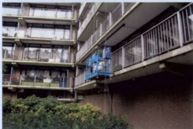
Ongeacht de hoogte, kan de hangbrug zijwaarts bewegen.
